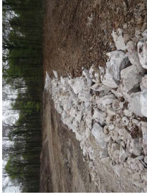
Exemple de tranchée drainante de l'assise du merlon des Effretais
